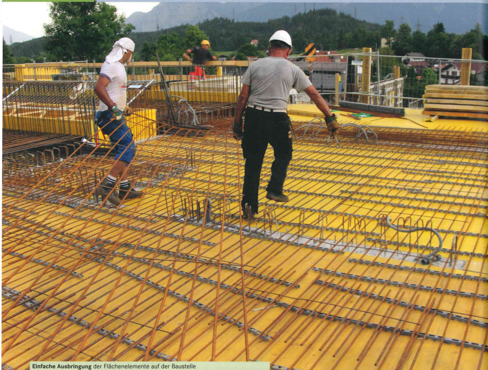
Einfache Ausbringung der Flächenelemente auf der Baustelle
